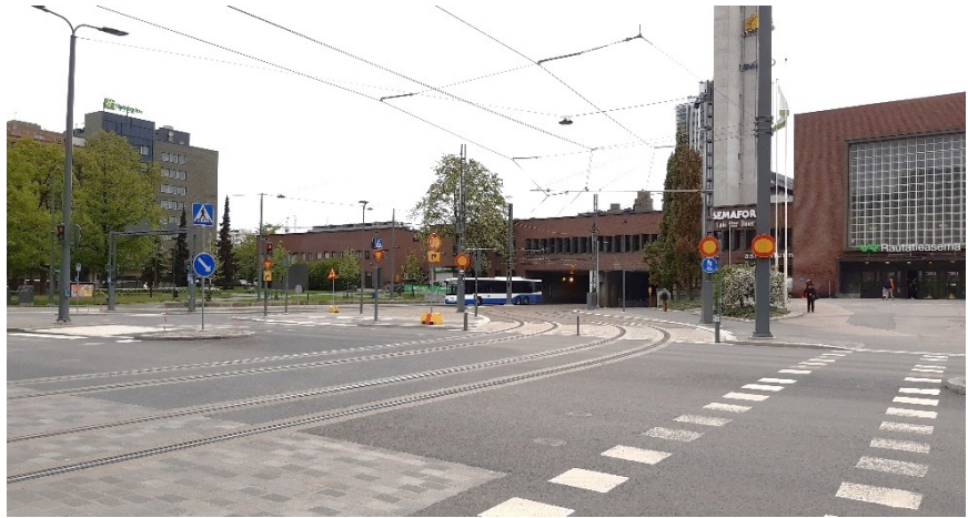
Näkymä Rautatiekadun ja Hämeenkadun risteyksestä kohti Itsenäisyydenkadun tunnelia ja Posteljoonipuistoa. (kuva: Tampereen kaupunki 2021)
